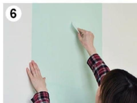
6 貼り付けた後、スキージーで上から下へ空気を抜いていきます。
