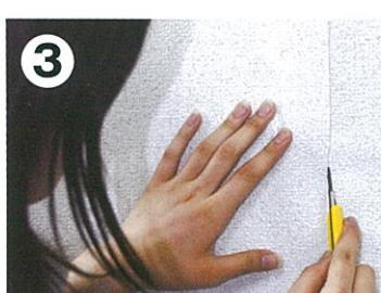
継ぎ目が見当たらない場合は壁紙の縦方向に切れ目を入れると、比較的簡単にはがすことが出来ます。壁紙の裏打ち紙が残っても構わないで、出来るだけ下地を傷めないように慎重に作業します。
