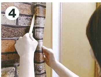
空気抜きが終わったら、次に壁紙の余計な部分をカットするために、竹べらを使って角を出していくます。
