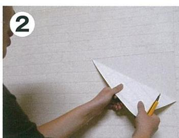
壁紙の上手（右利きであれば右上）から壁紙をはがします。角、切り継ぎ、重ね切りしているジョイント部分からはがすと剥がしやすいでしょう。
