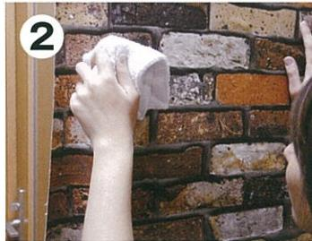
その後、スポンジ、タオルなどで少しぬらした後、撫でバケで空気を抜いて仕上げます。
