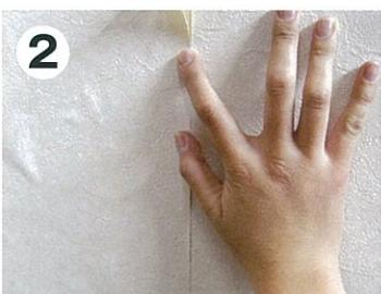
2枚目は1枚目の端に平行になるように合わせて、2、3mmすかした状態で仮貼りします。
