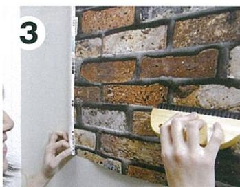
貼り終えたら、撫でバケで壁紙の上から下に空気を抜いていきます。壁紙がシワにならないように注意して作業をしていきます。
